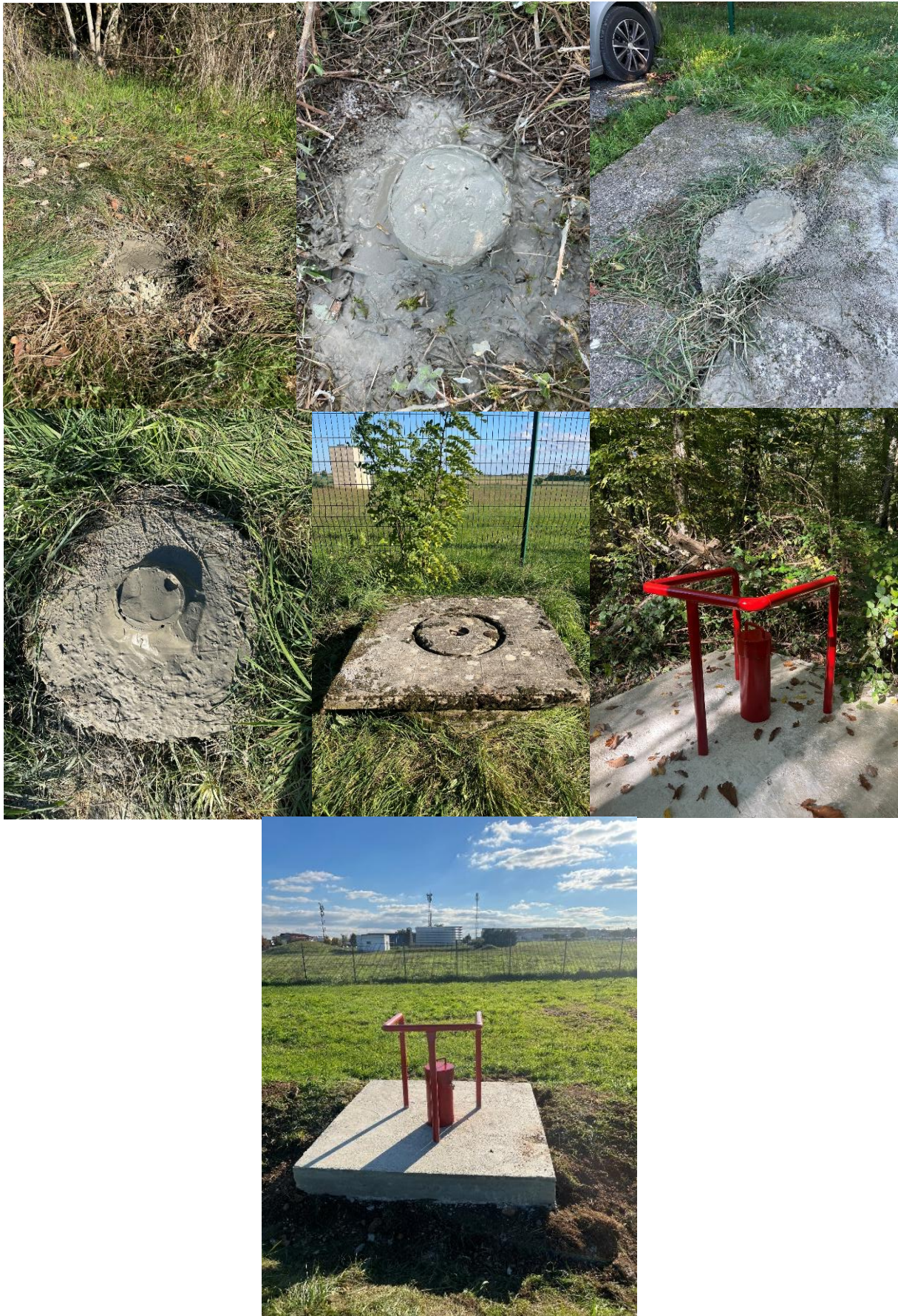
Photos 20 à 26 : ouvrages comblés ou réhabilités sur la nappe de Dijon Sud en 2025
