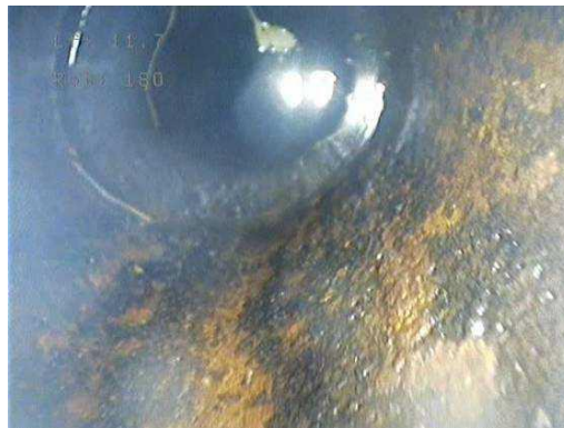
Figure 10 : image d'inspection télévisuelle d'un ouvrage
