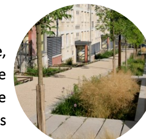
Noues végétalisées d'infiltration
